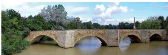
Abb. 1: Ulrichsbrücke über den Neckar in Köngen. [5]
