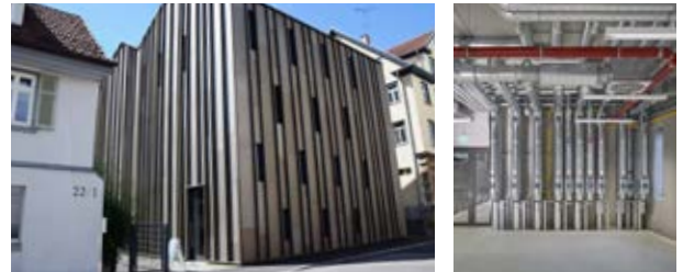
Das neue Laborgebäude der Fakultät Gebäude-Energie-Umwelt – von außen und innen.
