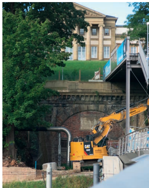
Abb. 2: Ehemaliger Bahntunnel unter Schloss Rosenstein, Zustand Sommer 2023 [3].
