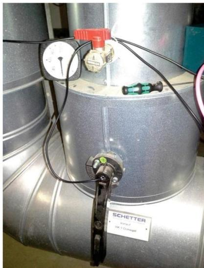
Verteileranschluss mit Entleerung und Absperrung
