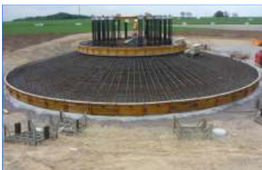
Fundamentierung einer Windenergieanlage (Bild: Juwi)
