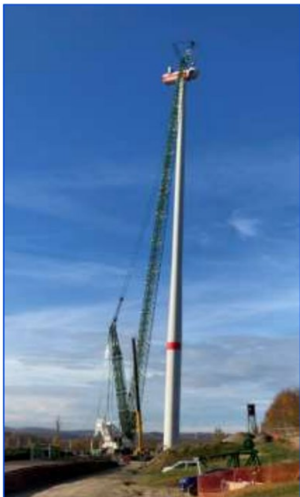
Kran zur Montage von Gondel und Rotorblättern (Bild: Juwi)
