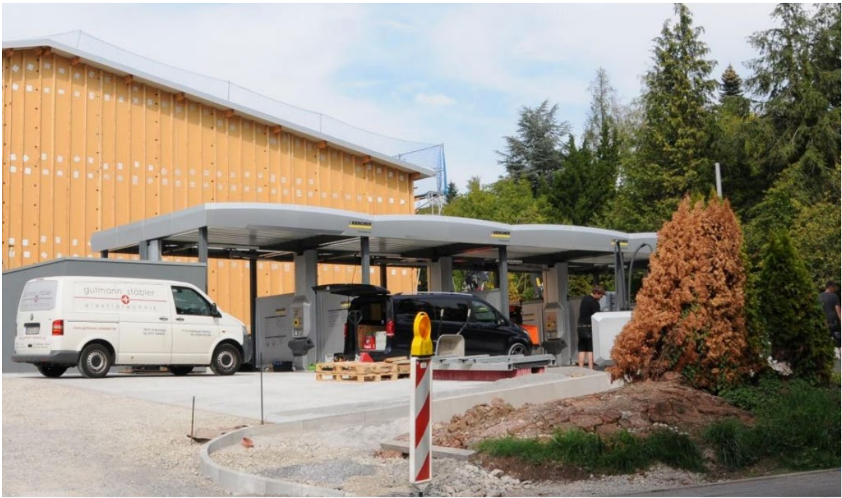
Fahrzeugreinigung: Eine Regenwassernutzung macht's möglich (Bild: Aris GmbH)
