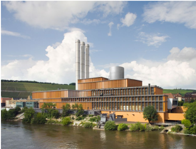
Unauffällig in die Gesamtansicht des Heizkraftwerks Würzburg einbezogen: Der neue große Heißwasserspeicher
