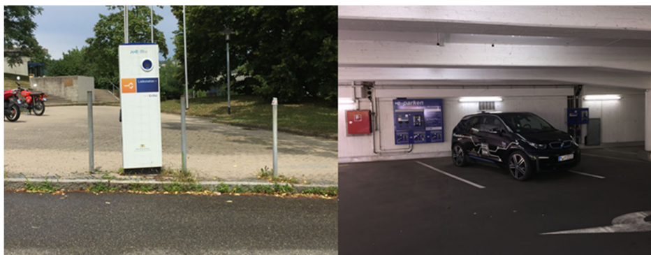
Abbildung 6-1: Ladeinfrastruktur für E-Autos am Standort Flandernstraße
