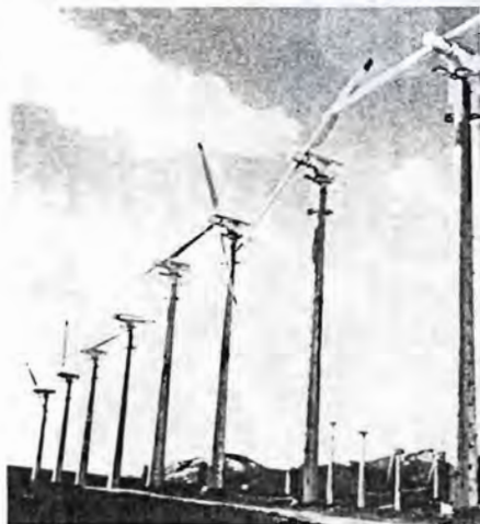
Beitrag zur Umweltentlastung: Windenergiekonverter
