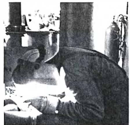
Installationsarbeiten an einer der zwölf Technikzentralen in den Untergeschossen des Bank- und Verwaltungszentrums am Stuttgarter Hauptbahnhof
