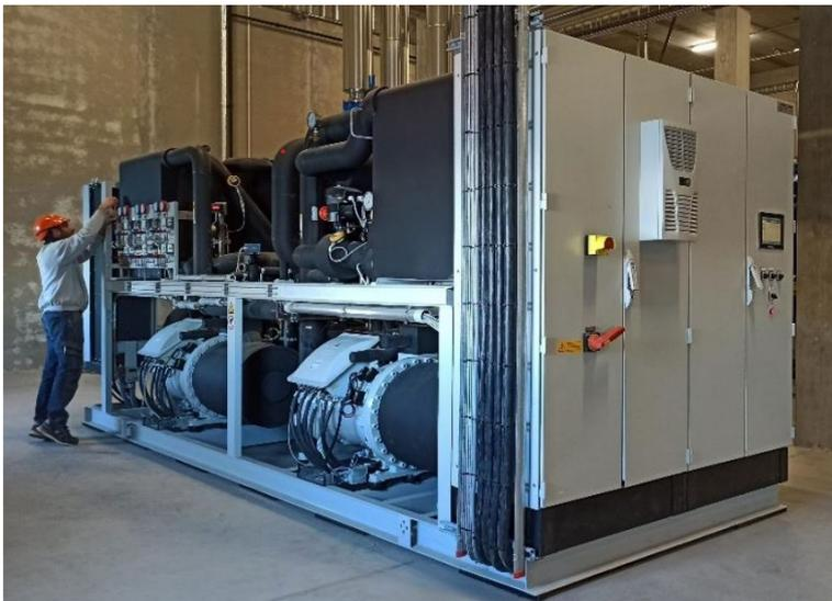
Bild 1: Industriewärmepumpe (Bildquelle: Combitherm GmbH)
